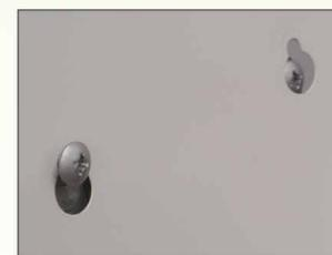
Particolare del fissaggio del disco mediante fori asolati
